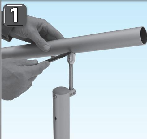
Handlauf an bereits vormontiertem Handlaufhalter positionieren und anzeichnen.
