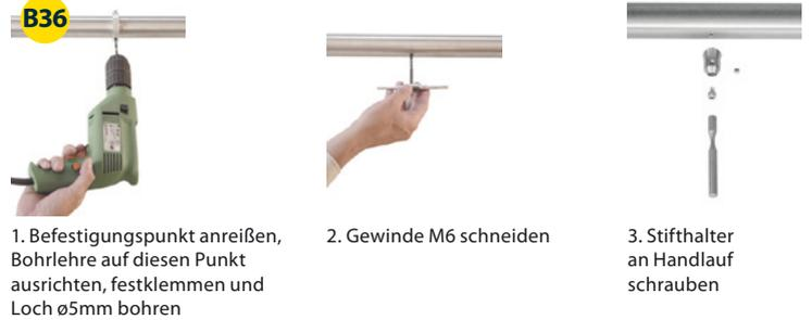
1. Befestigungspunkt anreißen, Bohrlehre auf diesen Punkt ausrichten, festklemmen und Loch  $\varnothing 5\text{mm}$  bohren
